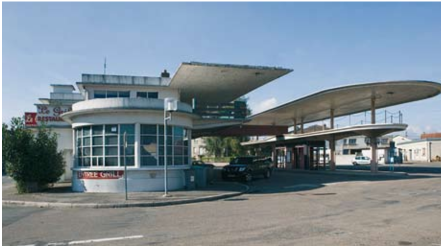
Gare routière de Gray, 2006 ©CRMH, Drac Franche-Comté
